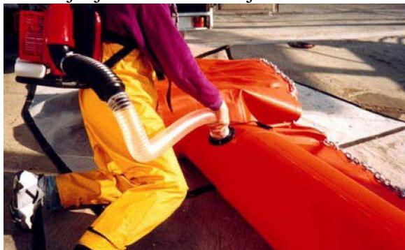
5.- Uklonite crijevo kada je komora napuhana do kraja i to brzo okrećući u smjeru suprotnom od kazaljki na satu. Ventil će se automatski zatvoriti. Zamijenite poklopac.
